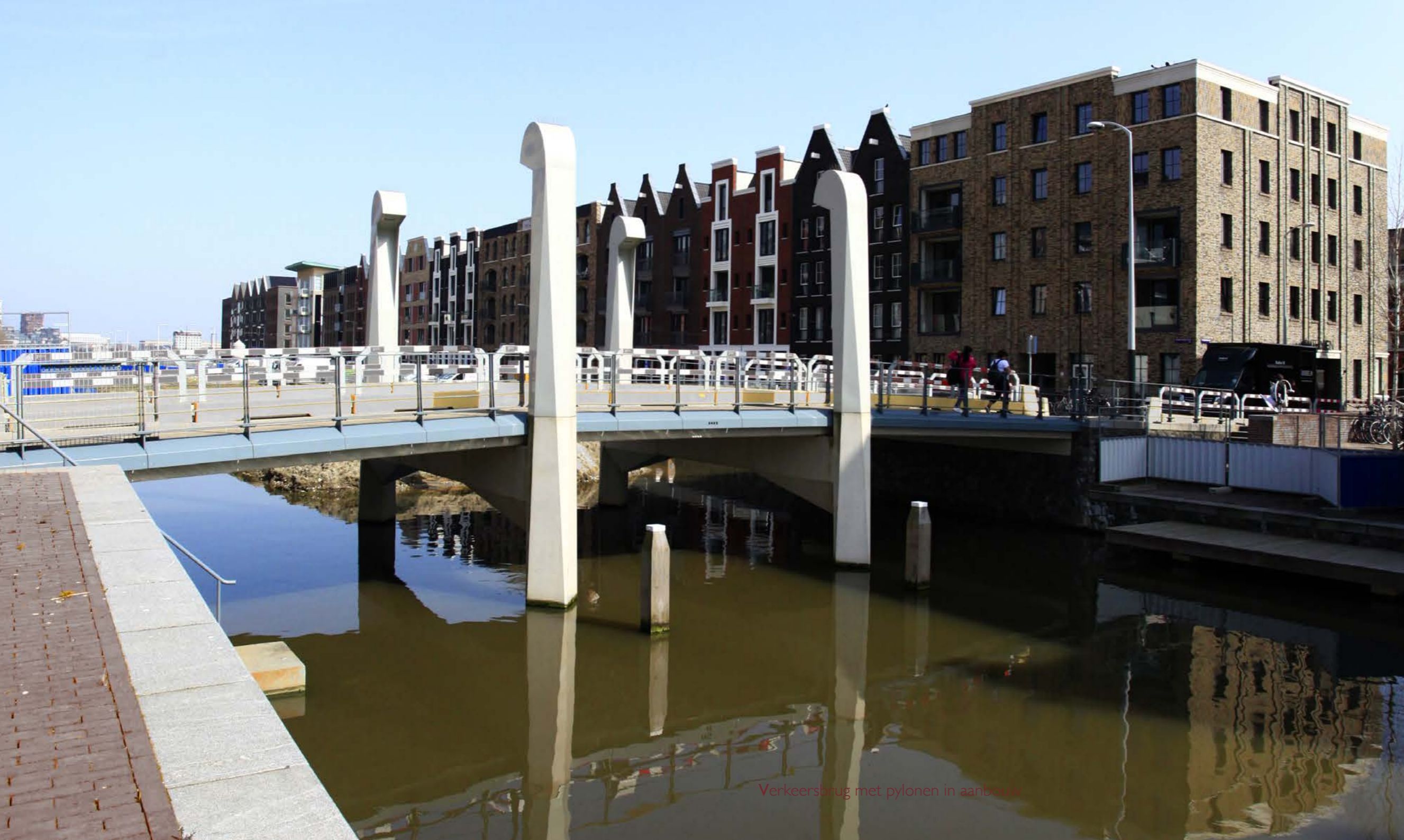
Brugtype A2: verkeersbrug met overspanning van 20 meter, breedte 8,50 meter, doorvaartprofiel 2,50 x 5,00 meter
