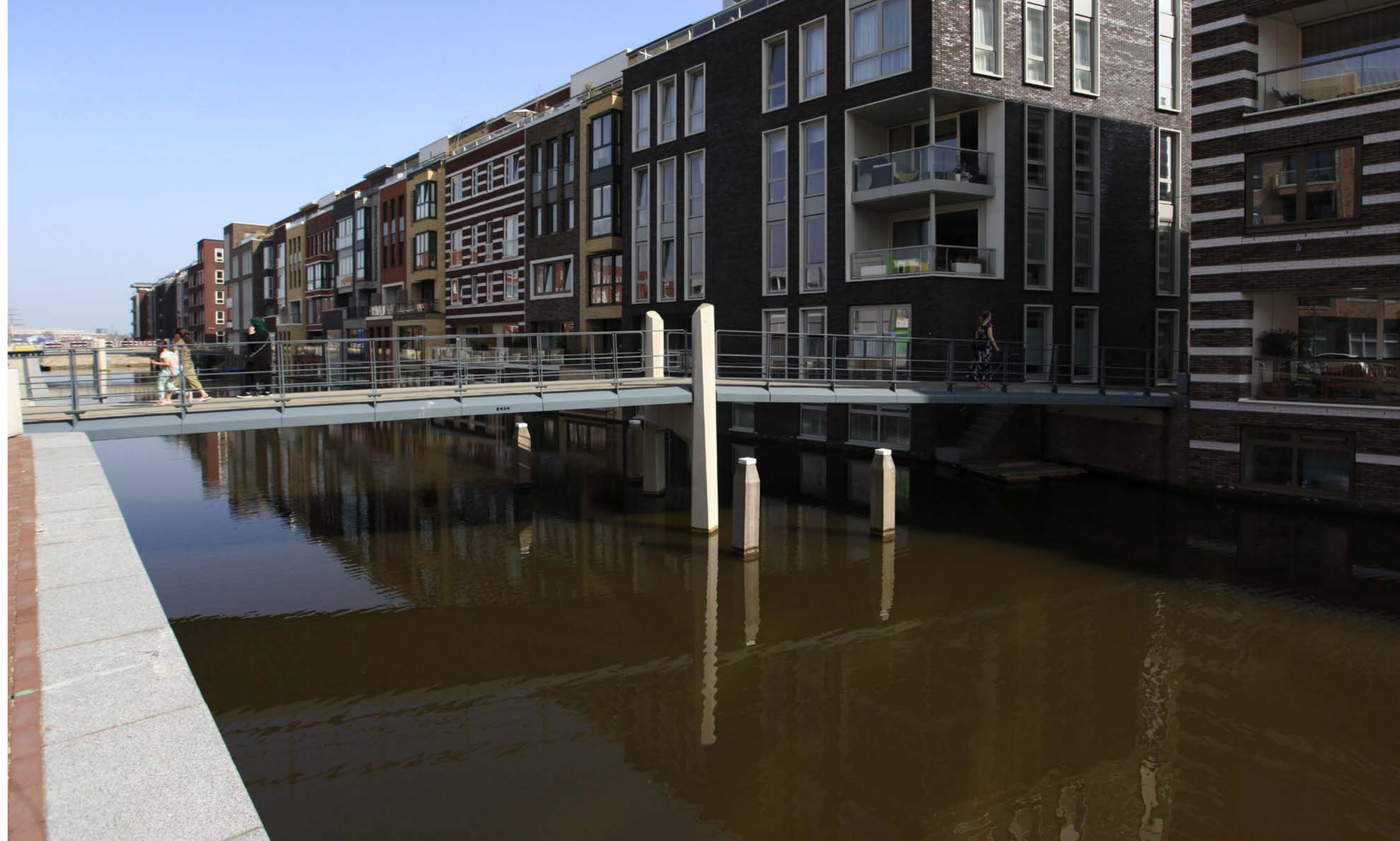
Brugtype BI: 3 voetgangersbruggen met overspanning van 20 meter, breedte 3 meter, doorvaartprofiel 1,90 x 5,00 meter
