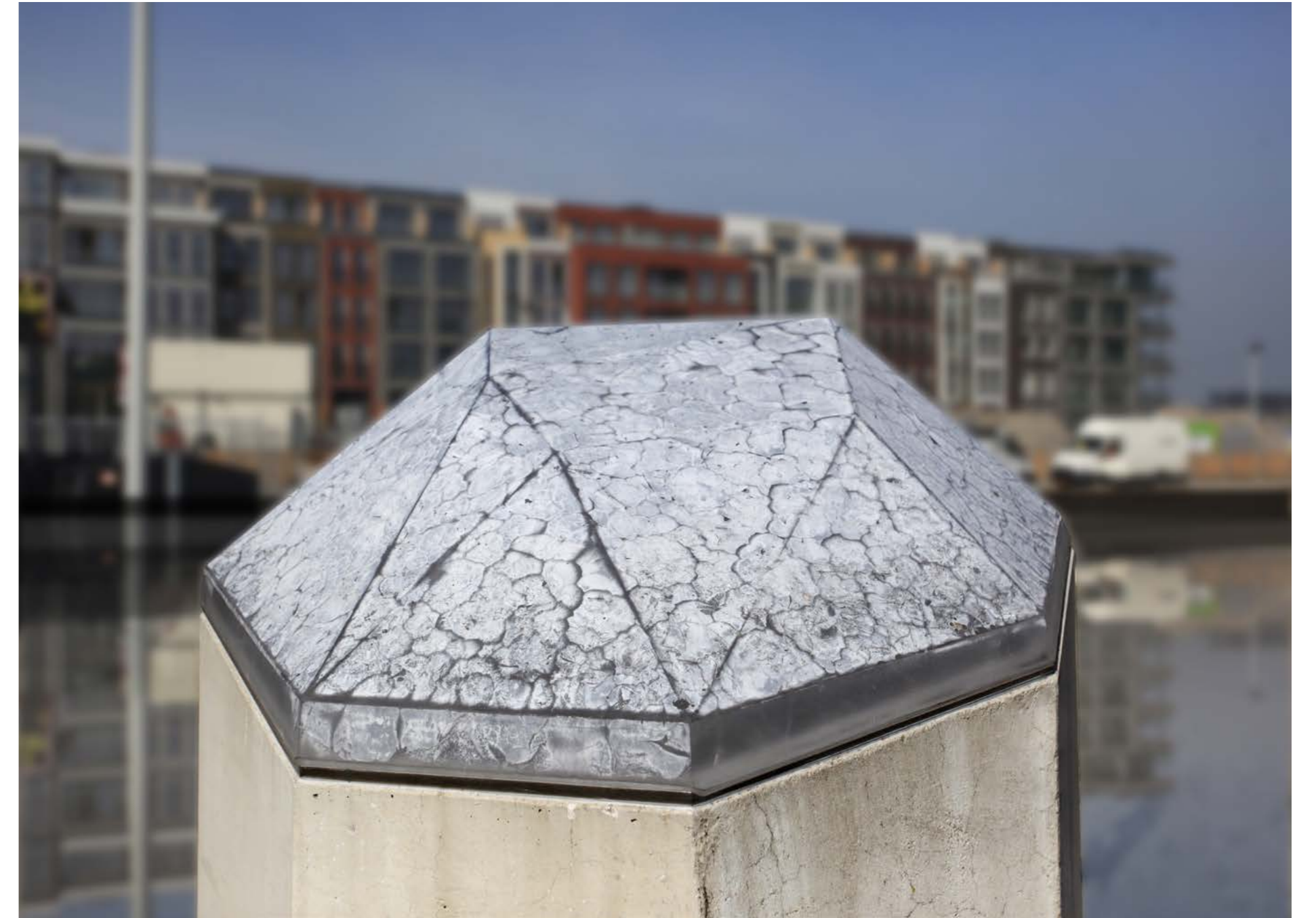
De gefacetteerde vorm van de ornamenten komt direct voort uit de veelhoekige vorm van de brugpijlers
