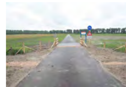
Het reeds aangelegde fietspad van asfalt.
