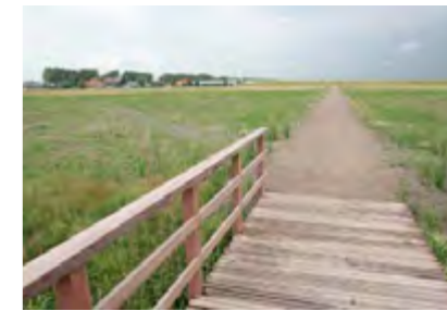
Het reeds aangelegde voetpad van duomix met brug over de kavelsloot.
